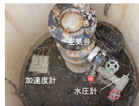
Fig. 3 加速度計と水圧計の設置状況
